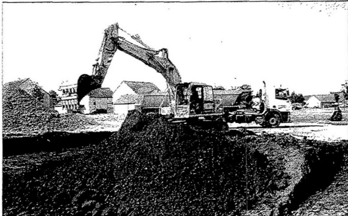
■ L'entreprise Cadoux TP, de Mercey-le-Grand (Doubs), s'est chargée des travaux de terrassement et de l'installation des réseaux. Photo ER
